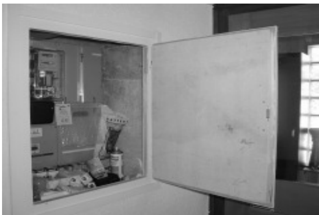
Coffret de disjoncteur avec plaque de protection anti-feu contenant de l'amiante à l'intérieur de la porte, photo IST
