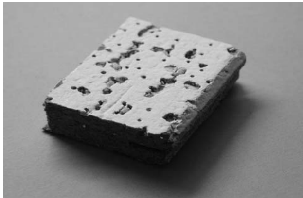
Partie d'un panneau acoustique (faux plafond) contenant de l'amiante, photo IST
