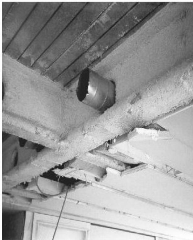
Flocage d'une structure métallique, photo IST
