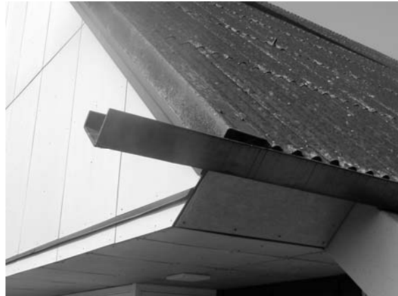
Toiture ondulée en fibrociment, photo IST
